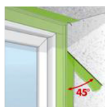
Strappare la pellicola con un'inclinazione di 45°
