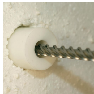
③ inserimento distanziale e foratura della muratura
