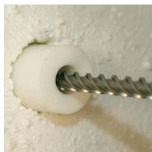
③ inserimento distanziale e foratura della muratura
